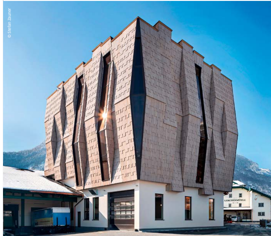
Zentrales Silogebäude mit Verladung und Mühle im Hintergrund
