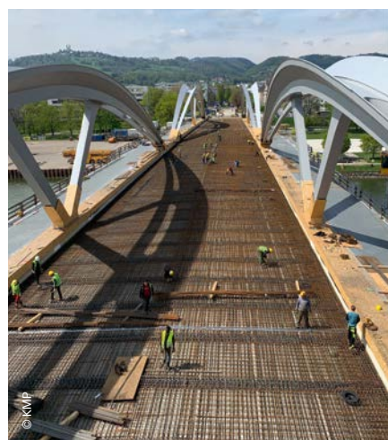
Bewehren der Fahrbahnplatte
