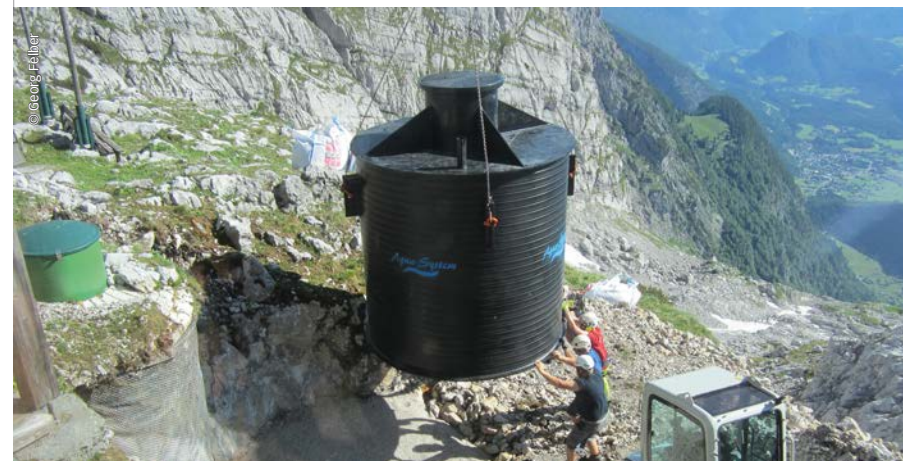
Keine Zufahrt, keine Seilbahn – alle Anlagenteile mussten mittels Hubschrauber präzise eingesetzt werden
