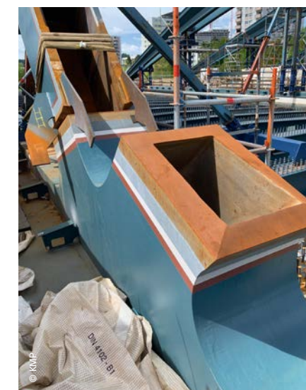
Zentraler Gussknoten mit räumlicher Nahtanarbeitung
