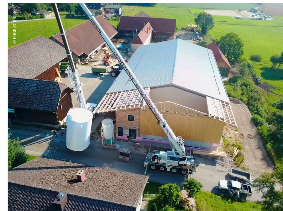
Punktgenaue Versetzung der Behälter mit zwei mobilen Schwerlast-Teleskopkränen
