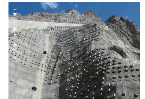
Widerlager der Bogenmauer mit vorgespannten Ankern, Drainage- und Zugangsstollen für Herstellung der Felsanschnitte
