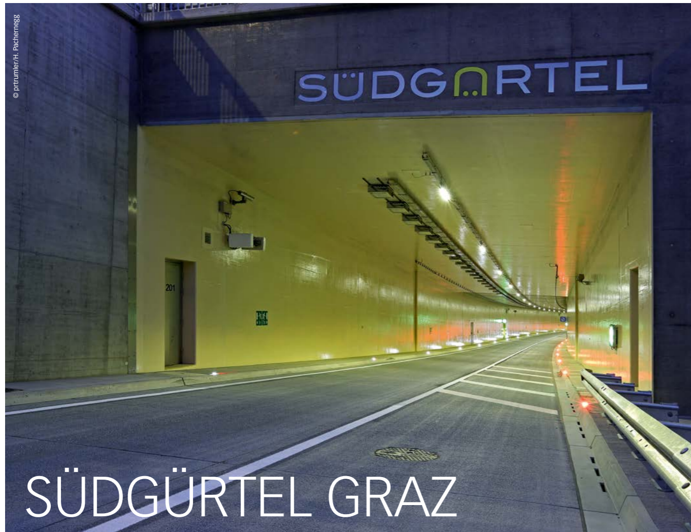
Portal Ost, Einfahrt Richtung Puntigam
