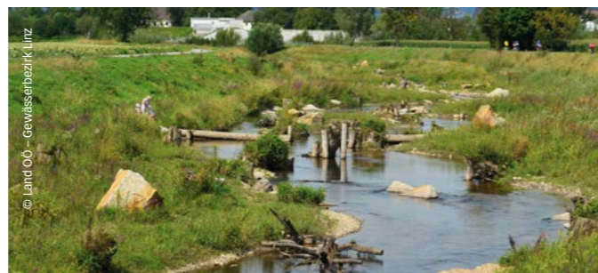
Renaturierung Kaindlau nach Fertigstellung der Feinarbeiten
