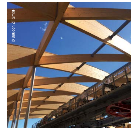
Dachkonstruktion mit bogenförmigen Holzleimbindern
