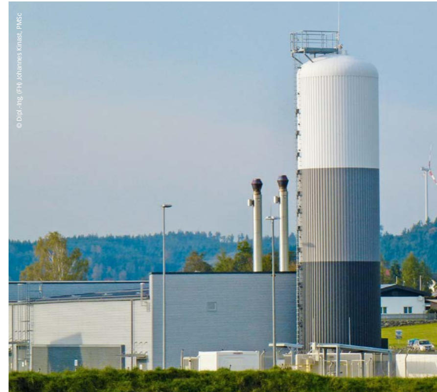
Gesamtansicht des Erdgas-Blockheizkraftwerks mit Wärmespeicher
