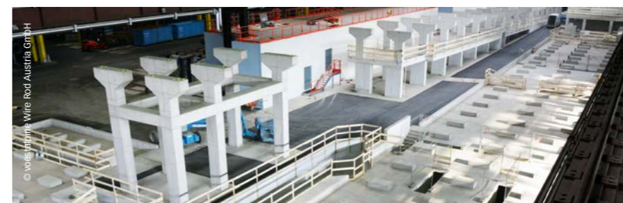
Kühlstrecke bzw. Bundmanipulation Betonbau Fertig (vor Anlagenmontage)
