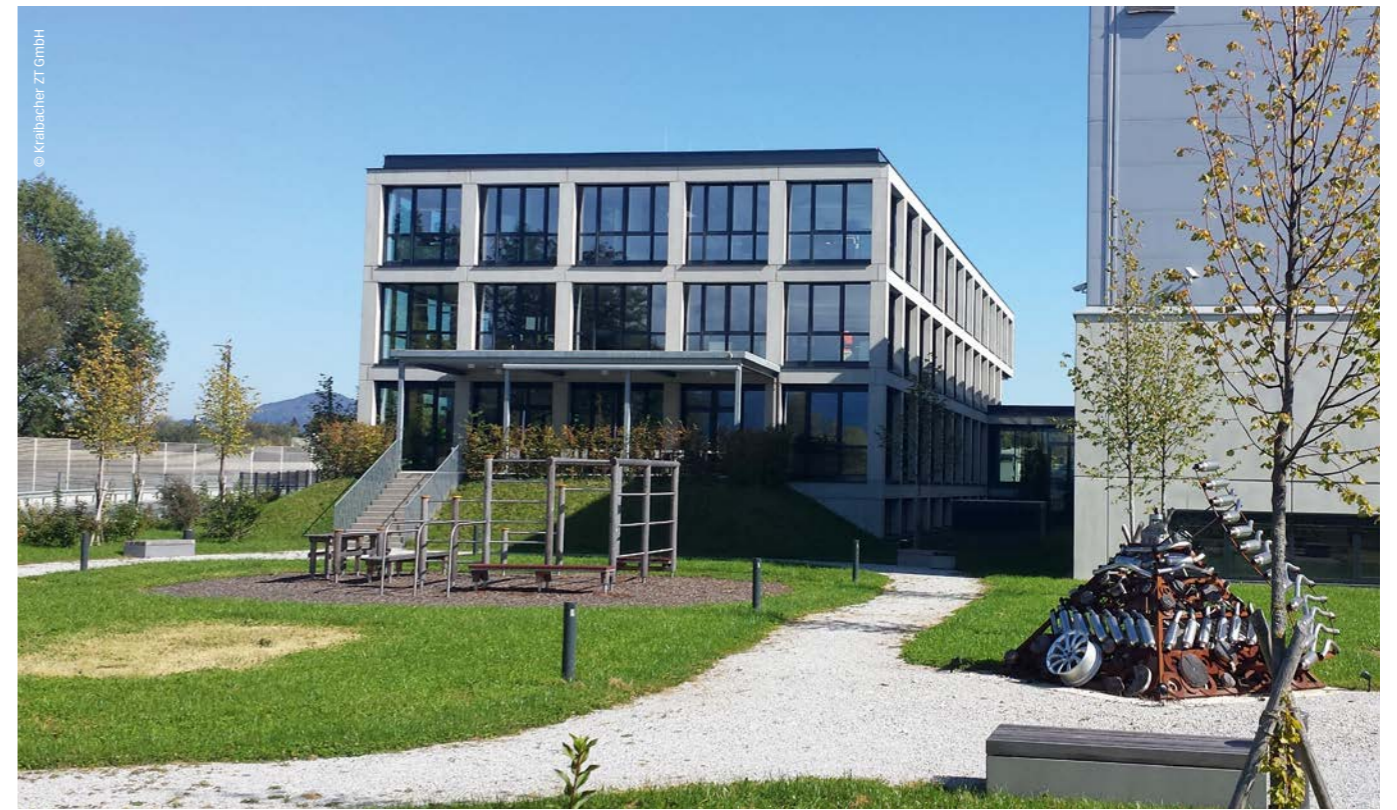
Fertiggestelltes Teilvertriebszentrum Porsche Siezenheim
