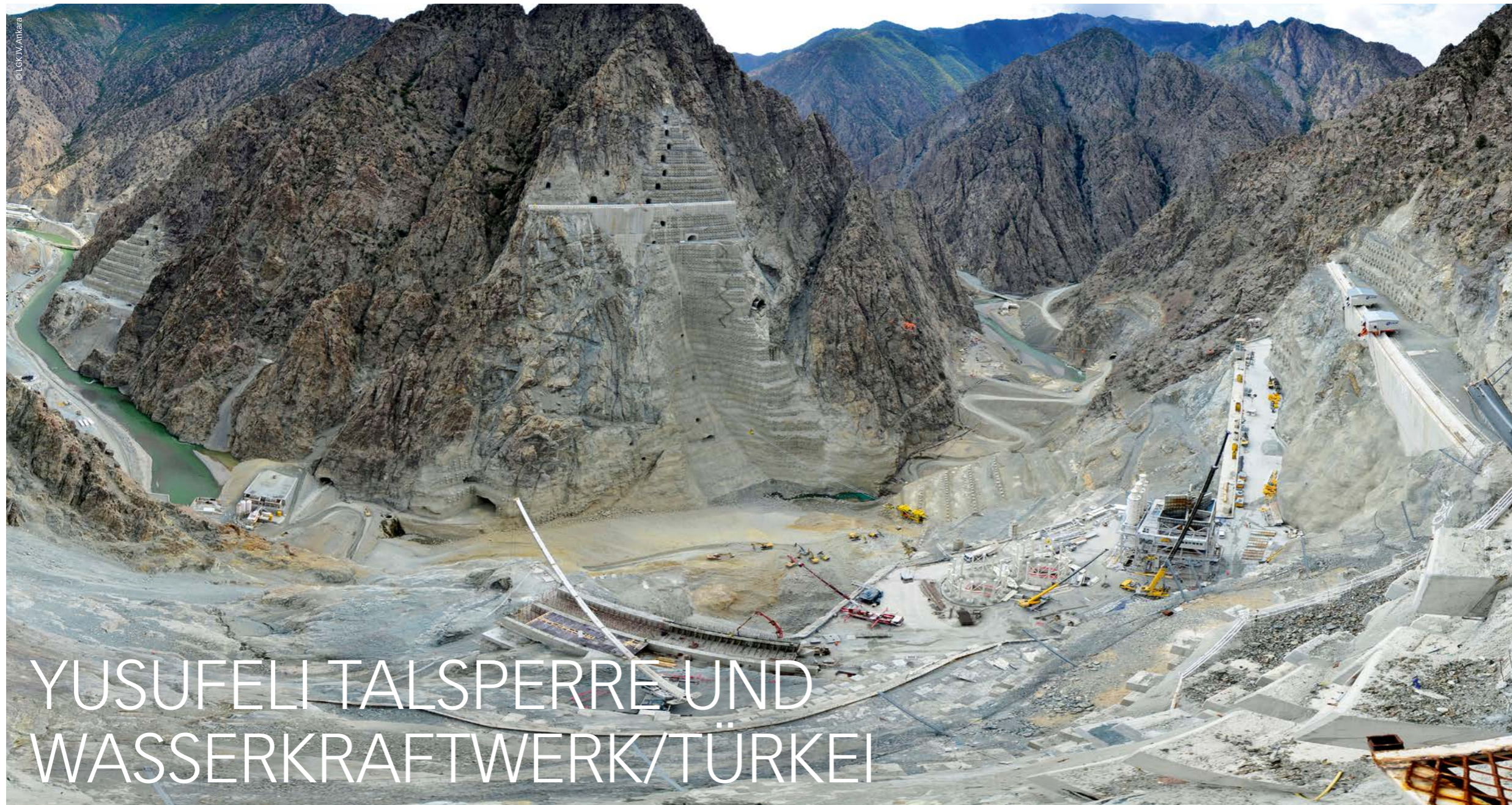
Widerlager der Bogenmauer mit vorgespannten Ankern, Drainage- und Zugangsstollen für Herstellung der Felsanschnitte
