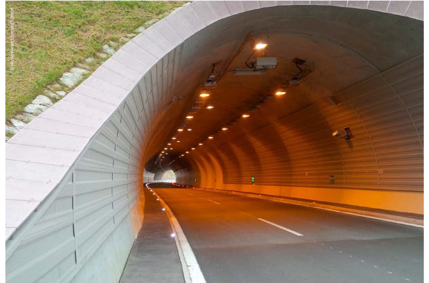
Innenansicht Tunnel Manzenreith
