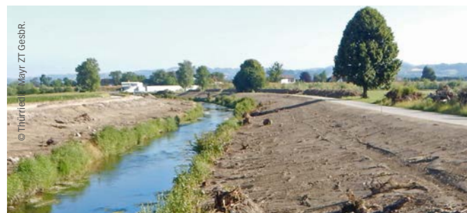
Kaindlau Regulierungsprofil bei Beginn der Bauarbeiten
