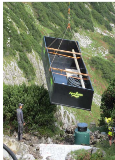
Versetzen der Anlagenteile mit dem Hubschrauber
