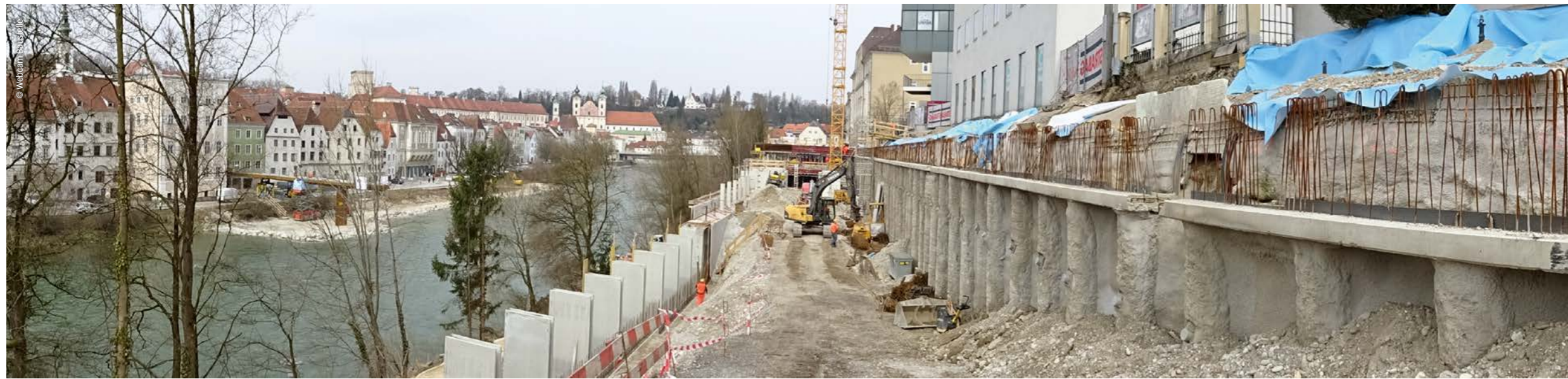
Flussseitige Fundamentscheiben und hangseitige verankerte Bohrpfehlwand
